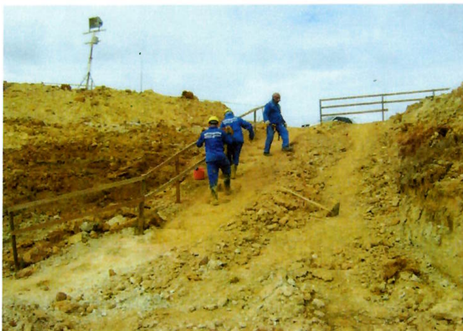
Figura 18- Utilização de corrimão para auxílio no acesso. Fonte: Arquivo pessoal, 2009.
