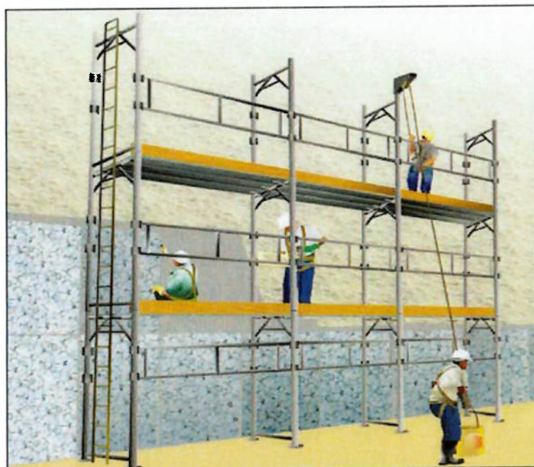
Figura 11: Modelo de andaime fachadeiro. Fonte: Fundacentro, 2009.
