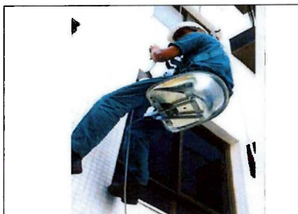
Figura 15: Andaime de cadeira suspensa. Fonte: www.mixandaimes.com.br , 2010.
