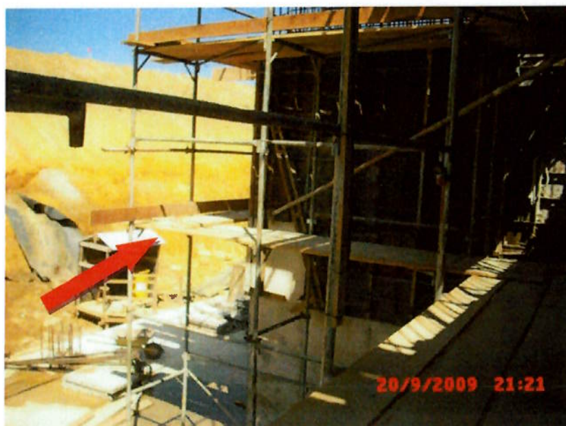
Figura 28: Inexistência de rodapés na plataforma inferior.
