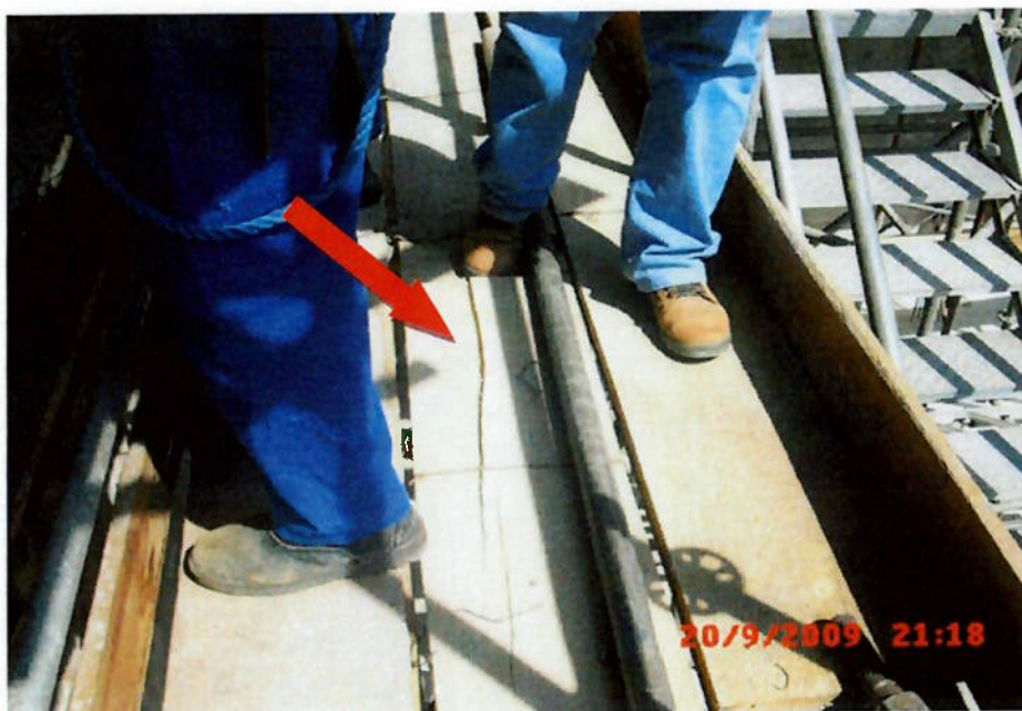
Figura 24: Detalhe da madeira com fissuras. Fonte: Arquivo pessoal, 2009
